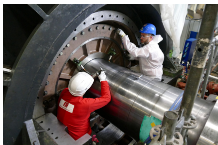
Salariés de l'entreprise Jeumont - remontage mécanique des paliers de l'alternateur
