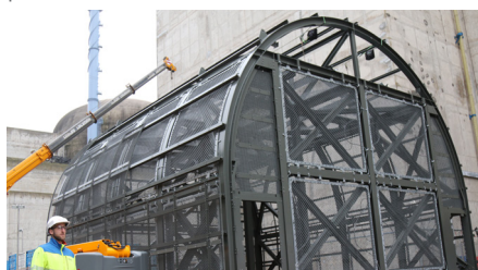
La charpente du DUS en cours de montage
