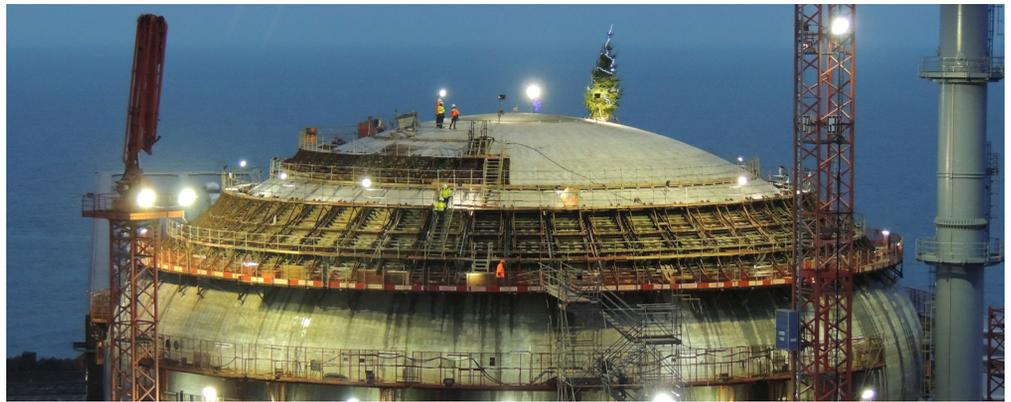
Appelée communément « le bouchon » par les équipes du fait de son faible volume, cette dernière levée de bétonnage représente quelques 100 m<sup>3</sup> de béton coulés pendant 6 heures environ ; les levées précédentes représentant 2000 m<sup>3</sup>. Après la pose du dôme en juillet 2013 qui, en venant fermer l'enceinte interne du bâtiment, avait permis son bétonnage puis sa mise en précontrainte\*, cet ultime
