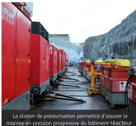
La station de pressurisation permettra d'assurer la montée en pression progressive du bâtiment réacteur.
