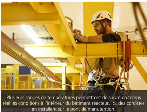
Plusieurs sondes de températures permettront de suivre en temps réel les conditions à l'intérieur du bâtiment réacteur. Ici, des cordistes en installent sur le pont de manutention.
