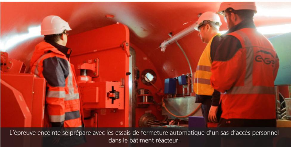
L'épreuve enceinte se prépare avec les essais de fermeture automatique d'un sas d'accès personnel dans le bâtiment réacteur.
