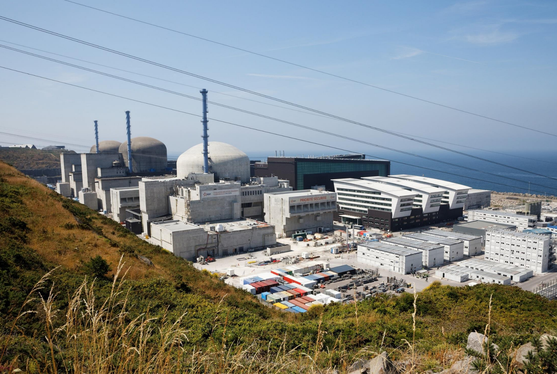
Le chantier EPR Flamanville 3 – 28 juin 2018
