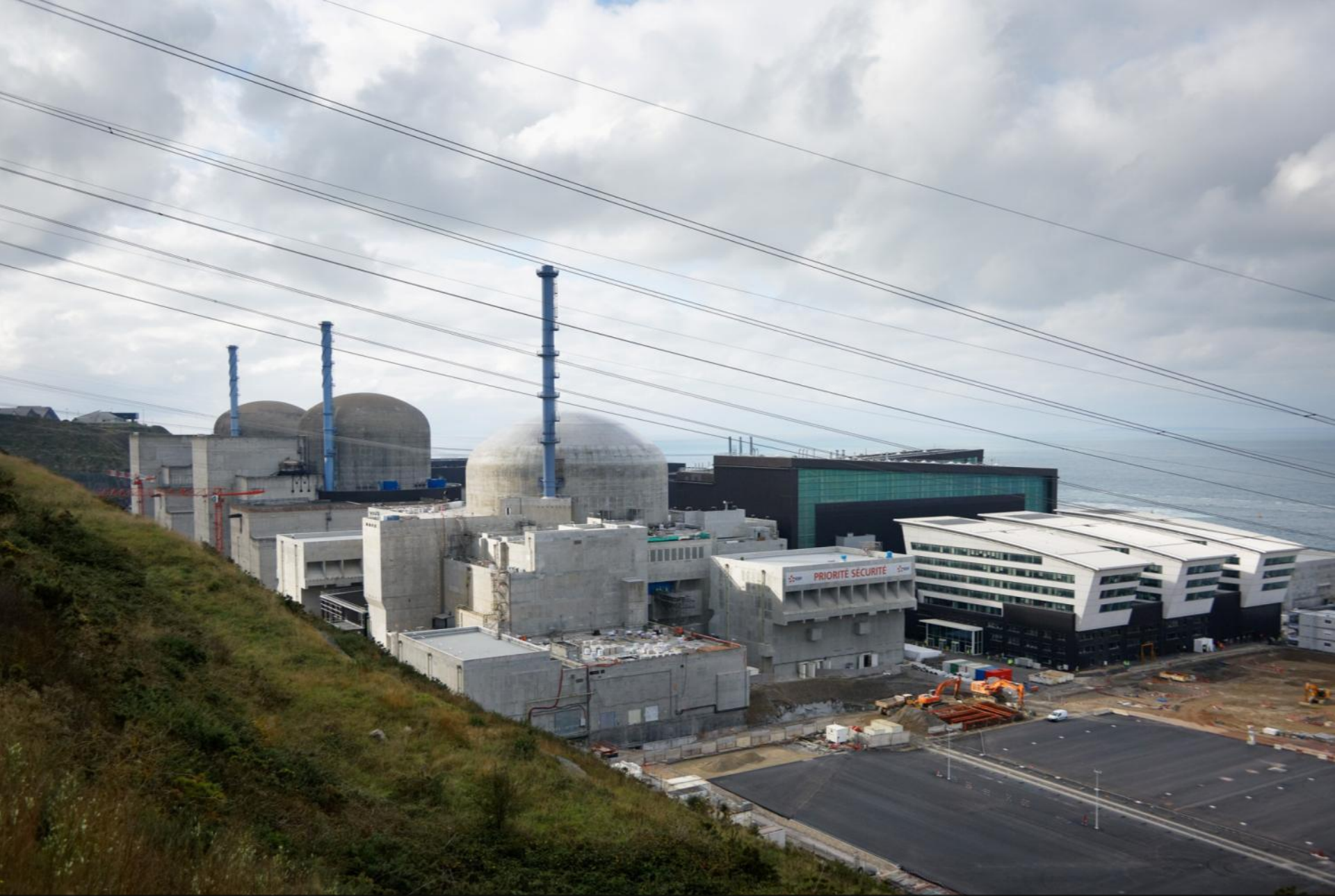
Le chantier EPR Flamanville 3 – 27 octobre 2016
