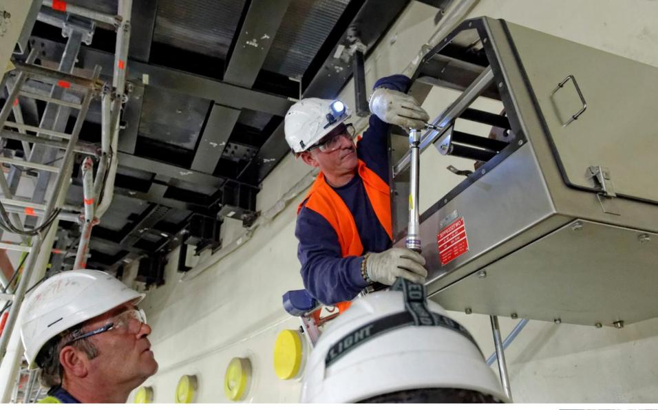
Installation des coffrets des traversées permettant de connecter les câbles électriques de part et d'autre de l'enceinte interne.
