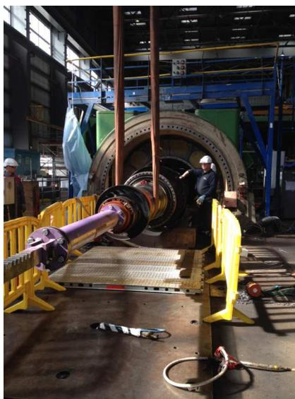
**La modernisation :** Une révision complète du rotor a été réalisée. Cette opération exceptionnelle consistait à sortir le rotor de la partie fixe de l'alternateur. Elle a permis de réaliser un diagnostic précis et les opérations de maintenance associées. La révision de cette pièce de 20 mètres de long et pesant près de 80 tonnes a été effectuée par des mécaniciens. Une fois réparé, le rotor a été remis en place et raccordé à l'alternateur.
