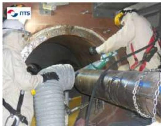
L'une des opérations majeures de ce chantier consiste à découper les 4 vases d'expansion des pompes secondaires. Ces objets sphériques, d'un diamètre de 5 mètres et d'un poids de 36 tonnes (cf photo ci-contre), sont découpés à l'aide d'une machine à câble diamanté dénommée « Clémentine », en référence à la découpe « en quartiers » qu'elle réalise.
