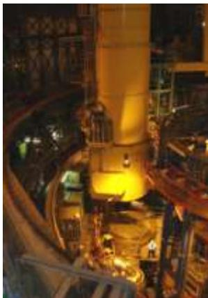
Les pompes primaires et les échangeurs intermédiaires nécessitent des manutentions plus complexes : en effet, ces composants sont initialement fichés dans la dalle surplombant la cuve du réacteur. Il faut donc les soulever en assurant une parfaite étanchéité autour de la traversée de la dalle, ce qui est fait au moyen d'une « hotte » de manutention suspendue au pont tournant du bâtiment réacteur.
