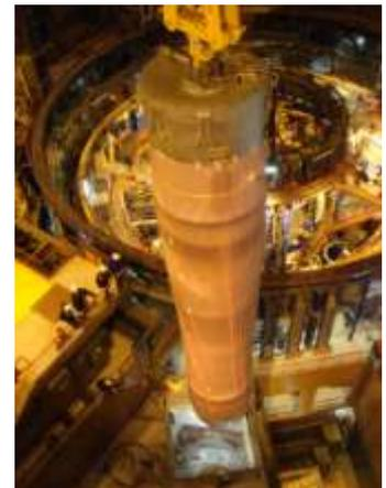
Les composants sont d'abord déposés dans un puits de lavage, pour y être débarrassés de la plus grande partie du sodium qui les recouvre, puis ils sont à nouveau transportés vers l'atelier de traitement pour y être découpés et conditionnés. Ces opérations ont débuté en octobre 2009, et se sont poursuivies jusqu'en 2012 où le 8<sup>e</sup> et dernier échangeur intermédiaire a été extrait de la cuve puis découpé.
