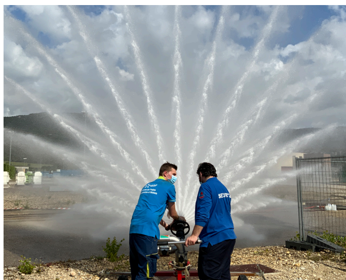
Photo prise sur le site lors d'un exercice incendie
