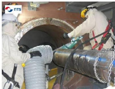
On appelle « tunnels secondaires » les quatre structures de 18 mètres de haut qui supportaient les pompes secondaires et une partie des circuits de sodium secondaire. L'objectif de ce chantier était de « faire de la place » dans le bâtiment réacteur, afin de préparer les opérations futures de démantèlement de la cuve du réacteur.
