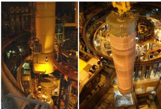
Les pompes primaires et les échangeurs intermédiaires nécessitaient des manutentions complexes : en effet, ces composants étaient initialement fichés dans la dalle surplombant la cuve du réacteur. Il fallait donc les soulever en assurant une parfaite étanchéité autour de la traversée de la dalle, ce qui a été fait au moyen d'une « hotte » de manutention suspendue au pont tournant du bâtiment réacteur.
