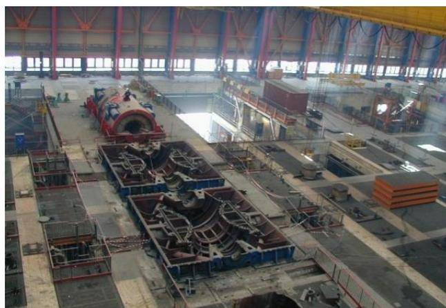
18 mois de chantier pour retirer tous les matériels de production d'électricité dont les 2 groupes turbo-alternateurs (620 MWe chacun), les condenseurs, les pompes... Hors béton, 17 000 tonnes de déchets ont été revalorisés à 95 % (métaux, calorifuge, tubes néon...).
