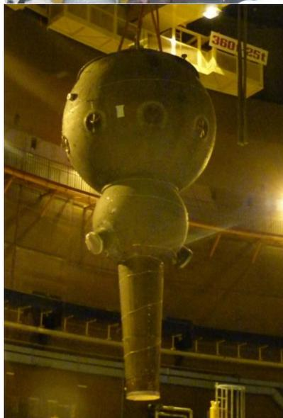
L'une des opérations majeures de ce chantier avait consisté à découper les 4 vases d'expansion des pompes secondaires. Ces objets sphériques, d'un diamètre de 5 mètres et d'un poids de 36 tonnes (cf photo ci-contre), ont été découpés à l'aide d'une machine à câble diamanté dénommée « Clémentine », en référence à la découpe « en quartiers » qu'elle réalise.
