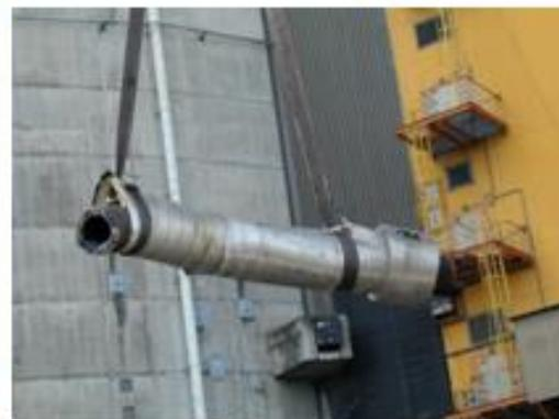
En 2002, 48 cheminées de rejet et de ventilation de 25 et 92 mètres, pour un poids compris entre 2 et 950 tonnes, ont été démantelées et évacuées avec 1.200 mètres de tuyauteries eau-vapeur.
