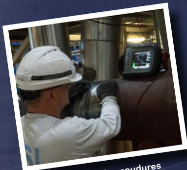
Contrôle des soudures
