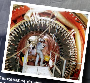
Maintenance du stator situé au cœur de l'alternateur dans la salle des machines
