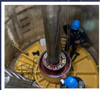
Maintenance de la pompe du condenseur, installation permettant de transformer la vapeur en eau
