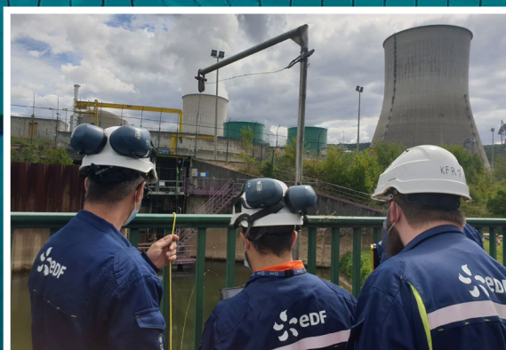
Mardi 7 juillet, le drone a fait sa première sortie en Meuse afin de réaliser l'inspection des grilles de la station de pompage du site.
