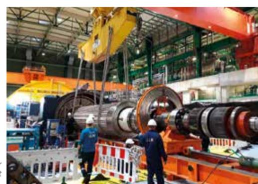
Extraction du rotor alternateur de l'unité n° 2 avant installation d'un nouveau.
