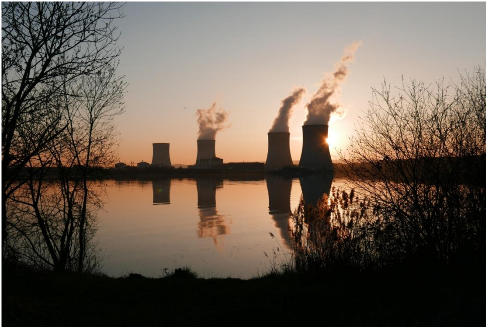
Centrale de Cattenom le 16 mars à 18h
