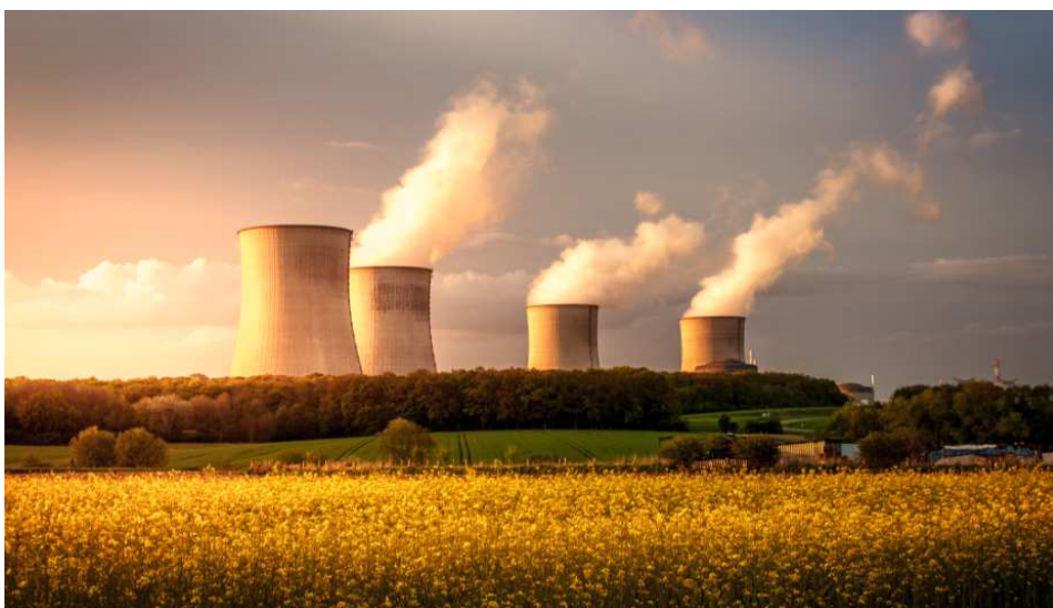
Photo prise par Fabrice Sartori, salarié de la centrale, pendant l'arrêt programmé pour maintenance de l'unité de production n°2 en 2017.
