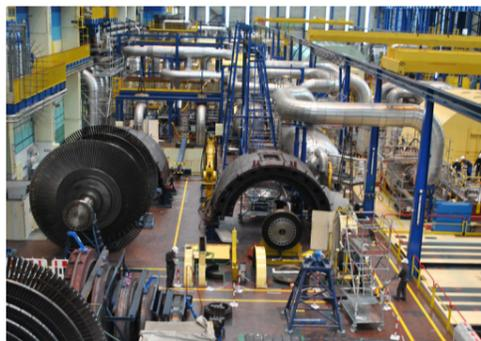
\* Situé en salle des machines, le groupe turbo-alternateur est composé de 3 turbines basse pression
