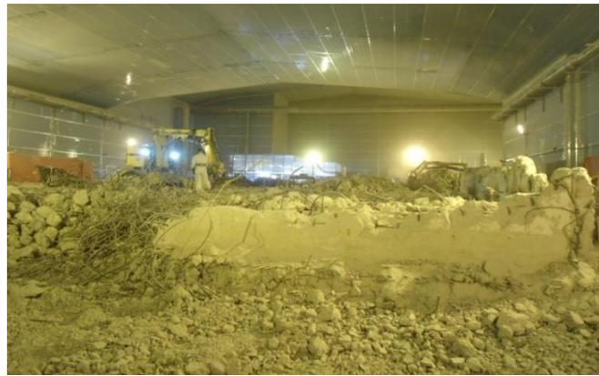
*Le Brokk® en action : démolition de murs et de plafonds (à gauche) et de la dalle (à droite).*
