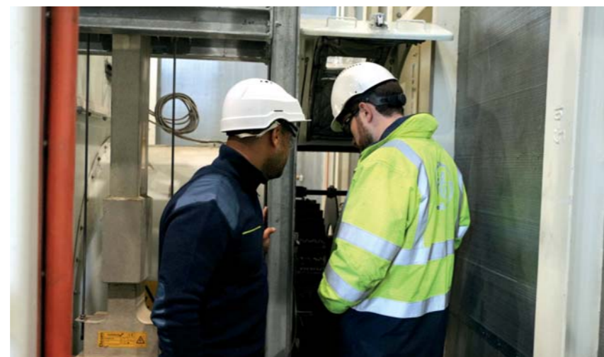
Vérifications sur l'alternateur, réalisées par les intervenants, lors de l'arrêt pour maintenance.
