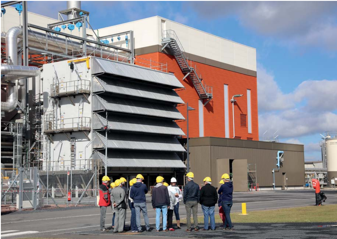
Les visiteurs découvrent le site du Cycle Combiné Gaz, implanté sur 35 hectares.
