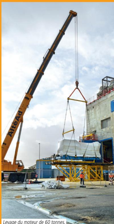
Levage du moteur de 60 tonnes.
