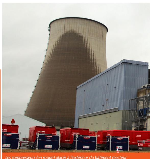
Les compresseurs (en rouge) placés à l'extérieur du bâtiment réacteur
