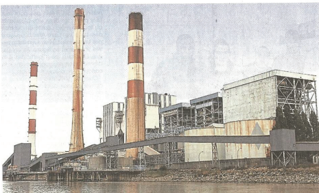
La centrale EDF de Cordemais. Les travaux qui débutent fin février porteront sur la modernisation des deux tranches qui fonctionnent au charbon.
