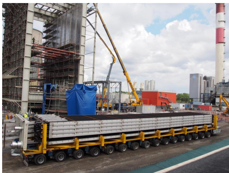
Arrivée du 1 er module de la chaudière, d'une longueur de 25 m et d'un poids de 100 tonnes, en août 2014
