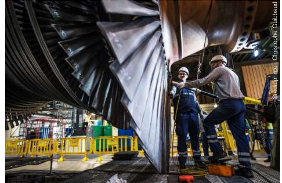
Centrale nucléaire de Cattenom, arrêt programmé de l'unité de production numéro 1, intervention de maintenance sur la turbine en salle des machines.
