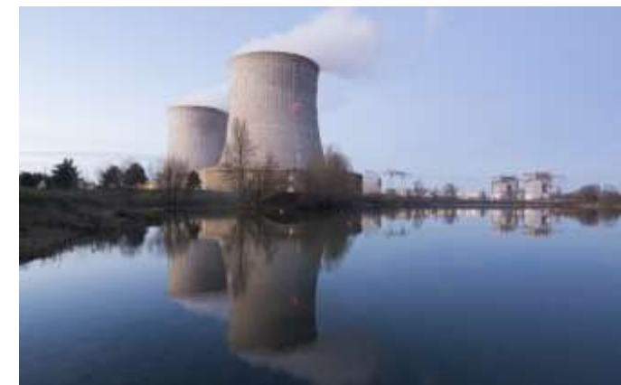
Aéroréfrigérants de la centrale nucléaire de Saint Laurent des Eaux aux bords de la Loire
