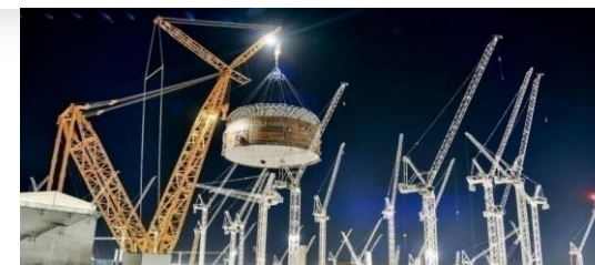
Pose du premier rondou du liner de confinement dans le bâtiment de l'Unité 1 réalisée avec succès en décembre
