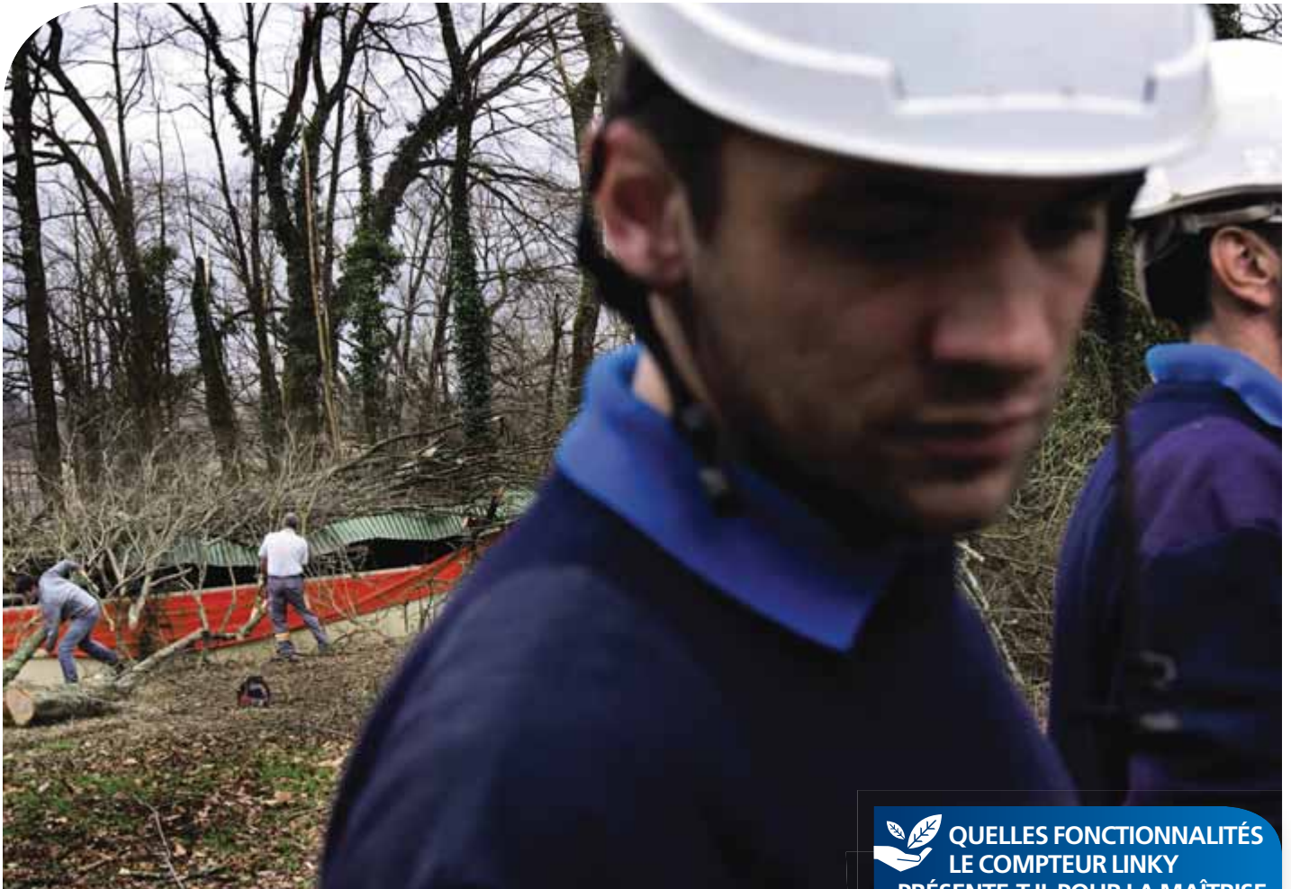
Reconstruction et mise en sécurité d'une ligne haute tension, dans les Landes. (EDF - Philippe ERANIAN)
