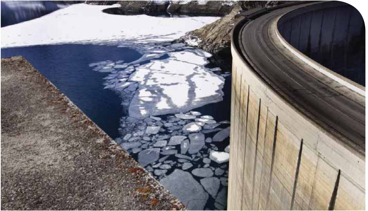
Barrage hydraulique de Tignes, en Savoie. (EDF - Philippe ERANIAN)
