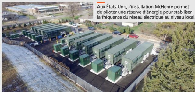
Aux États-Unis, l'installation McHenry permet de piloter une réserve d'énergie pour stabiliser la fréquence du réseau électrique au niveau local.
