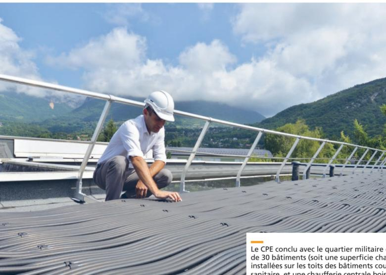
Le CPE conclu avec le quartier militaire de Roc Noir portait sur la rénovation énergétique de 30 bâtiments (soit une superficie chauffée de plus de 41 500 m<sup>2</sup>). Les moquettes solaires installées sur les toits des bâtiments couvrent désormais 30 % des besoins en eau chaude sanitaire, et une chaufferie centrale bois couvre plus du tiers des besoins en chauffage du site.
