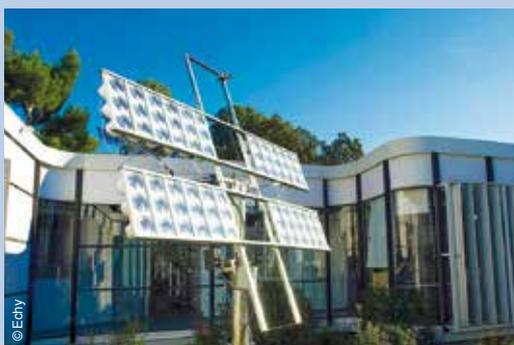
tables, collectent et concentrent la lumière du soleil. Des fibres optiques transportent la lumière naturelle jusqu'aux pièces à éclairer. Lorsque la lumière solaire n'est pas suffisante, elle est automatiquement complétée par un éclairage à LED.
