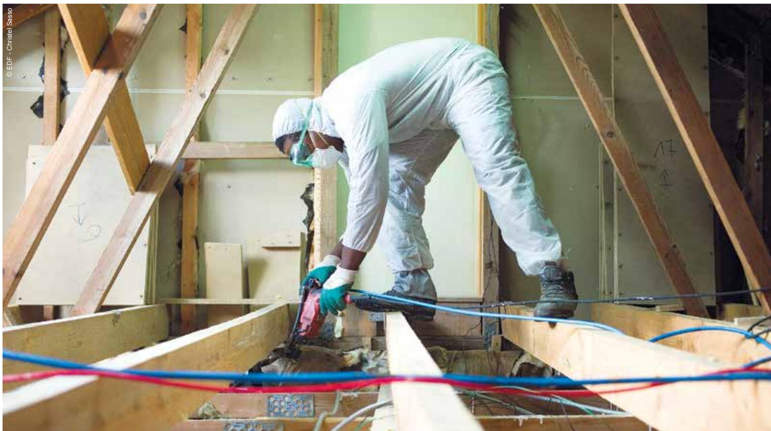
Chez un particulier, isolation de l'habitat par l'intérieur. Pose d'une nouvelle isolation au mur ainsi qu'au sol par soufflage de flocons de laine de roche.
