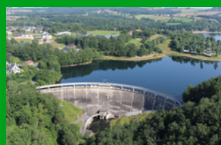
Barrage de Pont de Salars (12)
