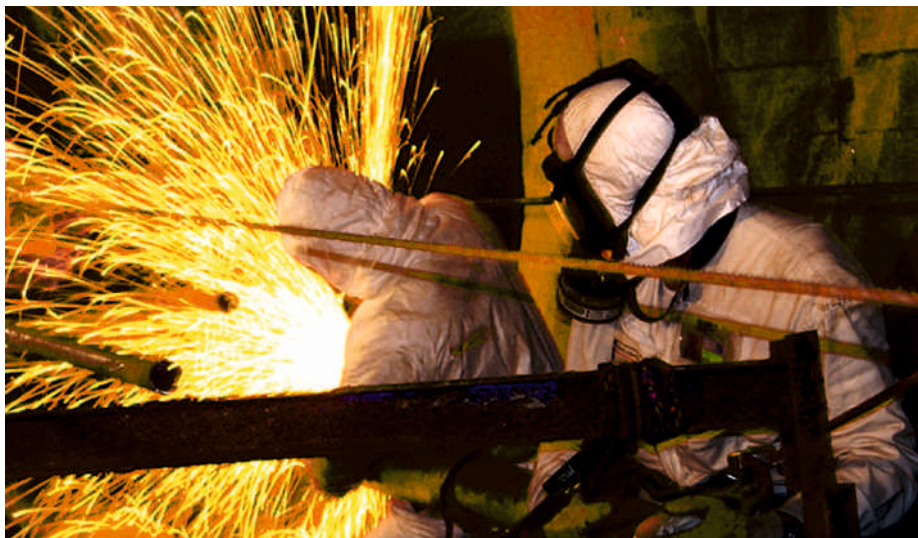
Découpe de tuyauteries à Chooz-A (Source : Ciden)
