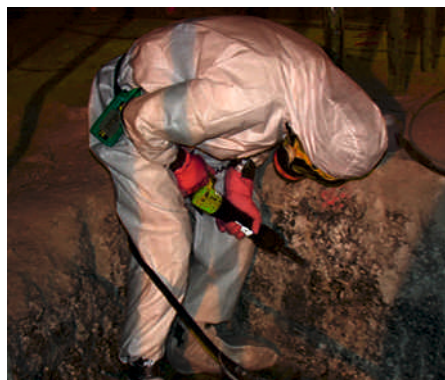
Masque Phantom PPR2000® (Source : Saint-Laurent et Brennilis)
