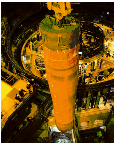
Extraction d'un échangeur de la cuve et sa découpe à Creys-Malville (Source : Ciden)
