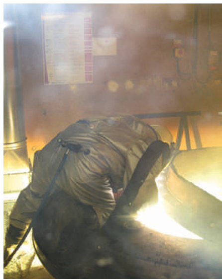
Extraction d'un échangeur de la cuve et sa découpe à Creys-Malville (Source : Ciden)
