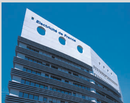
Siège EDF Division Production ingénierie à Saint-Denis
