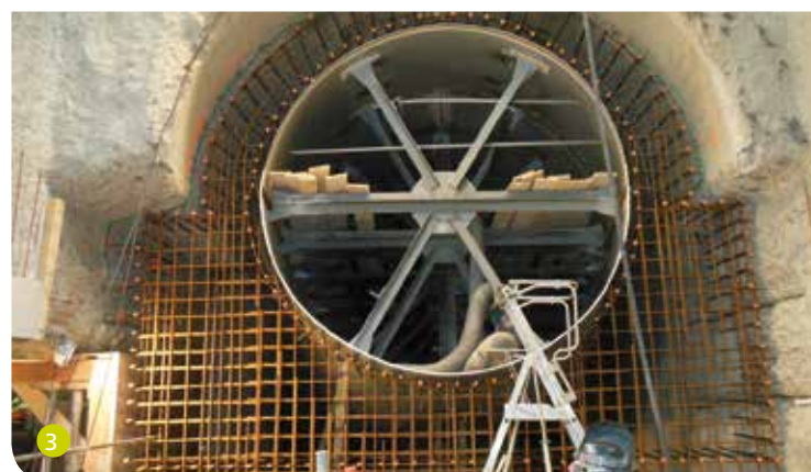
3 Afvoerpijp van een van de twee nieuwe groepen. In de pijp werden metalen staven aangebracht om vervormingen door de betonstorting te vermijden. Na de uitharding van het beton werden de metalen staven terug verwijderd.
