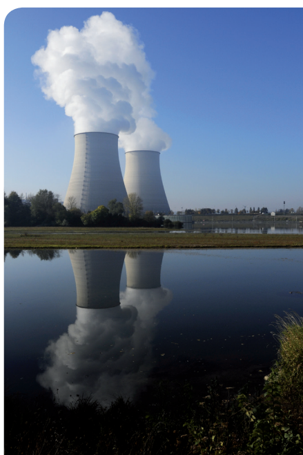
Centrale nucléaire de Belleville
