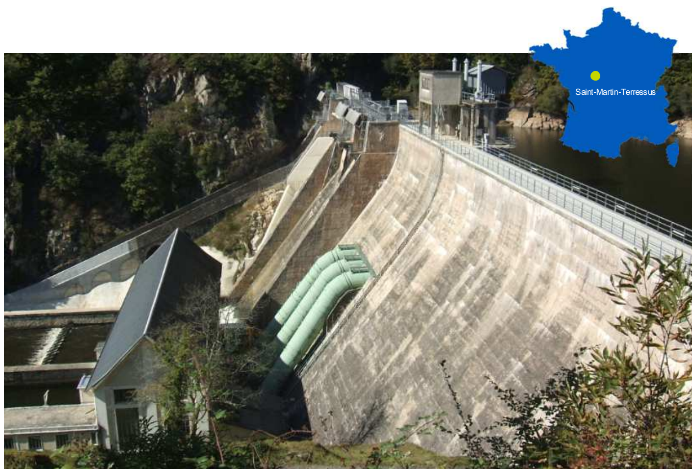
Barrage et centrale hydroélectrique de Saint-Marc EDF © Aurélien Brunet
