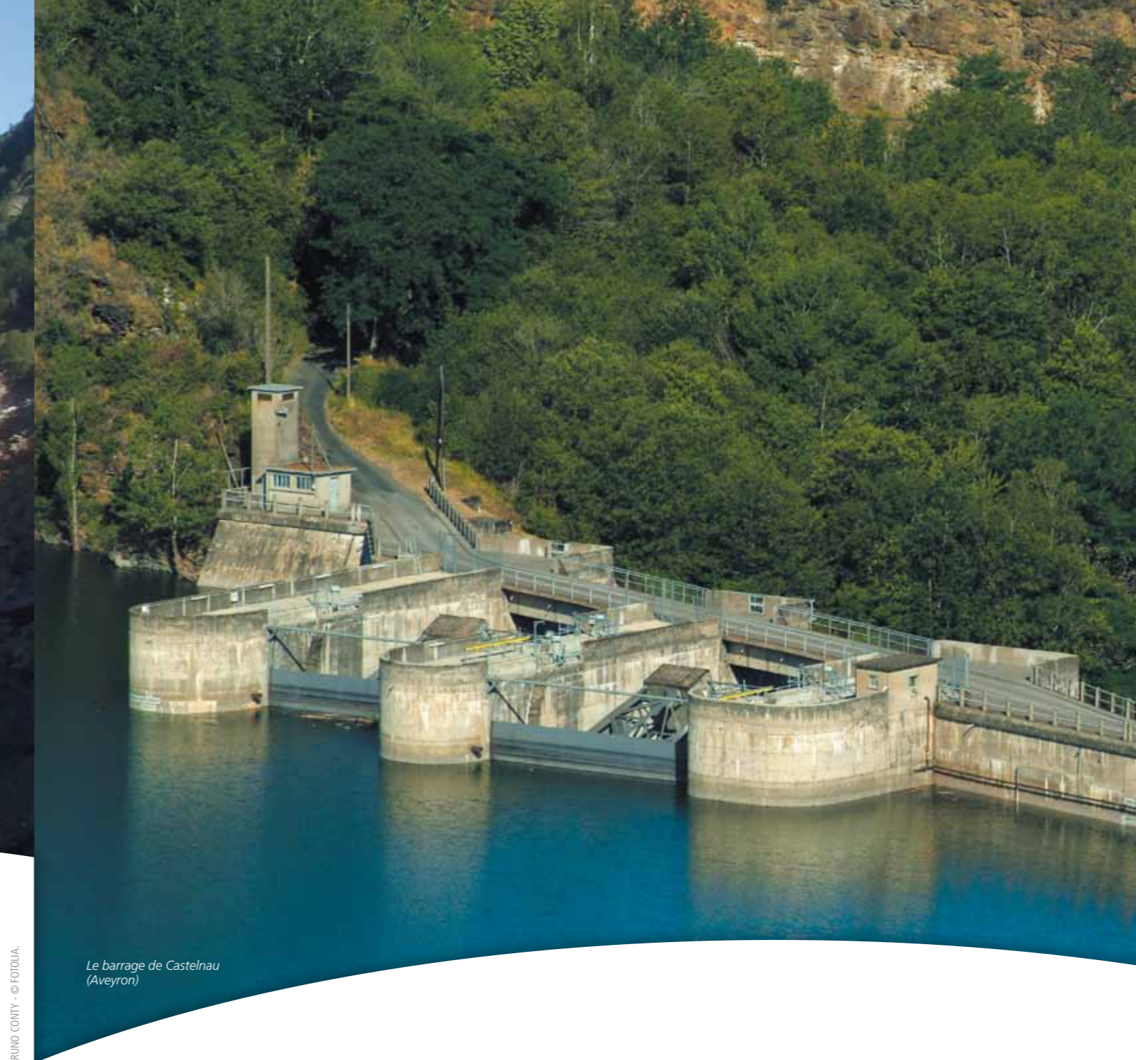
Barrage de Laparan (Ariège). Un des grands réservoirs exploités par EDF qui soutient le débit des rivières en période sèche.
