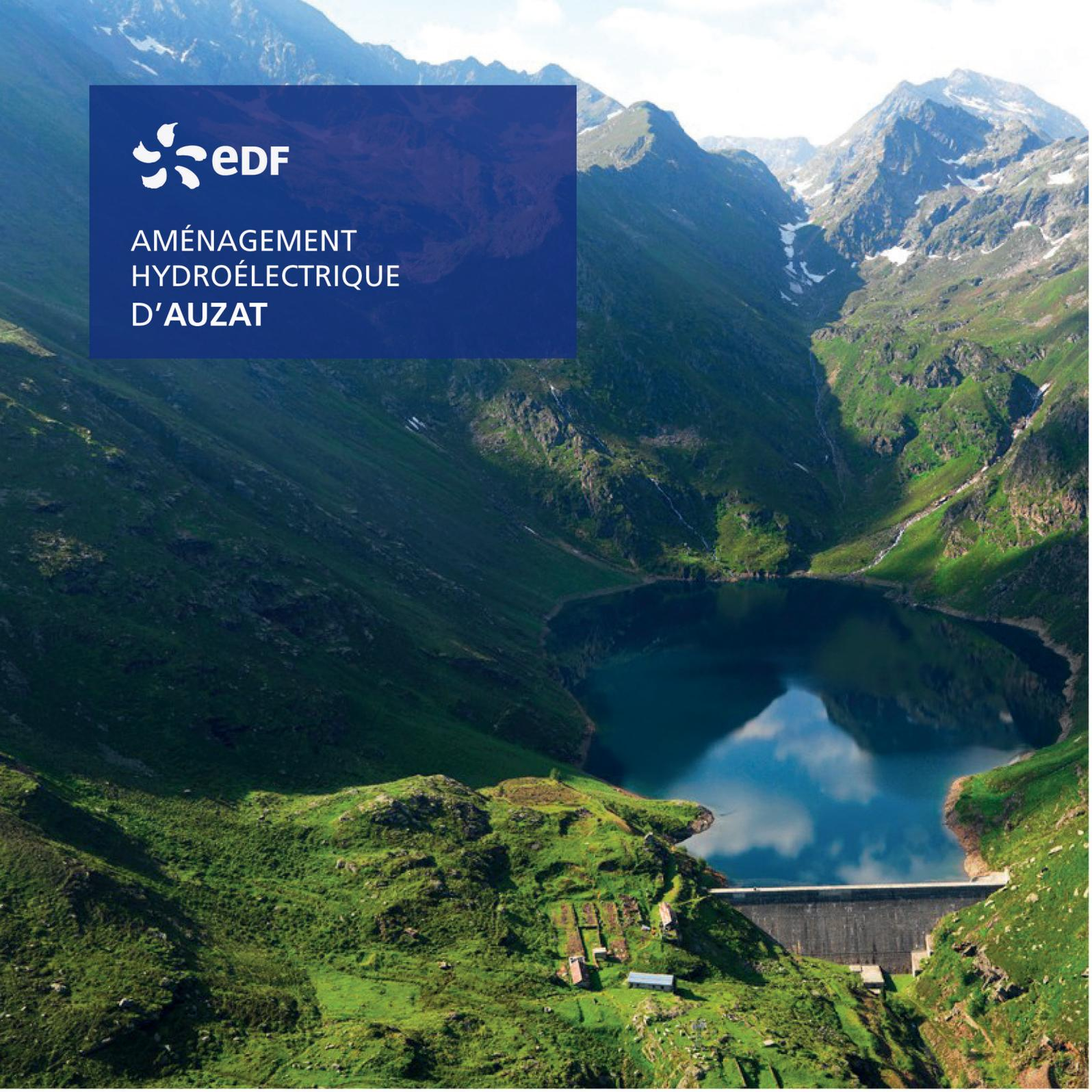
L'aménagement hydroélectrique d'Auzat est composé des centrales hydroélectriques d'Auzat, Soulcem, Pradières, Bassiès et Sabart dans la vallée du Vicdessos, affluent rive gauche de l'Ariège. Ces centrales utilisent l'eau des rivières des Pyrénées dont la majeure partie est retenue dans les barrages Majou, Escales, Gnioure, Izourt et Soulcem, lors de la fonte des neiges.
