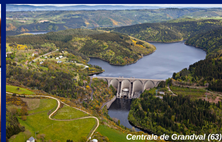
Centrale de Grandval (63)
