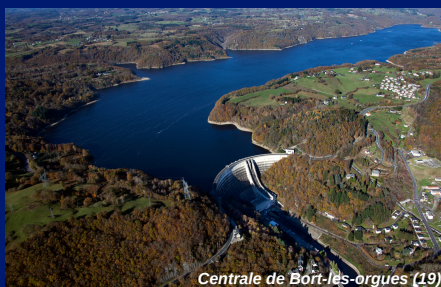
Centrale de Bort-les-Orques (19)
