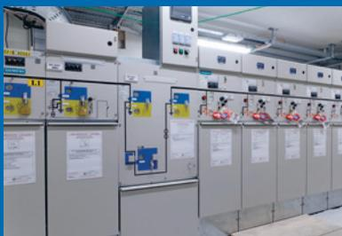
câbles haute tension HTA (20 000 volts), les premières armoires de distribution électrique ont été installées et mises sous tension en octobre.
