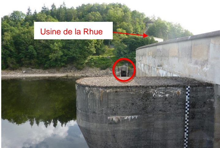
Vue amont du barrage de Bort.
