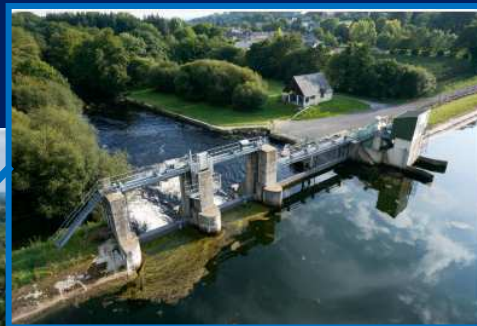
Barrage de St-Aignan : en terre / 155 m de long / 6 m de haut / Equipé de 2 évacuateurs de crue (vannes)
