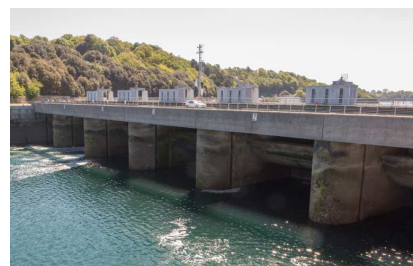
Jusqu'à 9 600 m 3 /s d'eau peuvent passer au travers des vannes.
