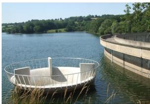
Puits de déversement en forme d'entonnoir permettant d'évacuer un débit de crue de 40m<sup>3</sup>/s.
