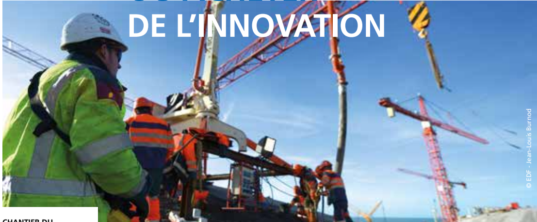
CHANTIER DU TERMINAL MÉTHANIER DE DUNKERQUE Bétonnage du dôme d'un réservoir
