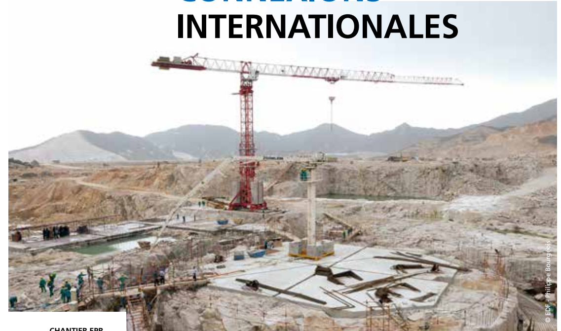
CHANTIER EPR DE TAISHAN Province du Guangdong, Chine
