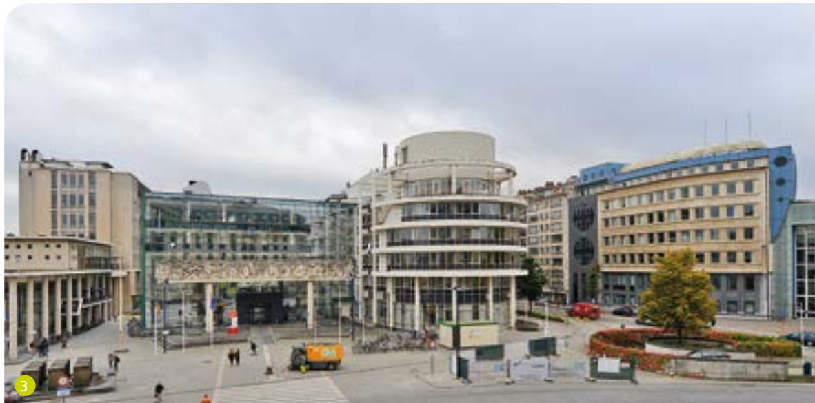
3 Le centre administratif sud de la ville de Gand.
