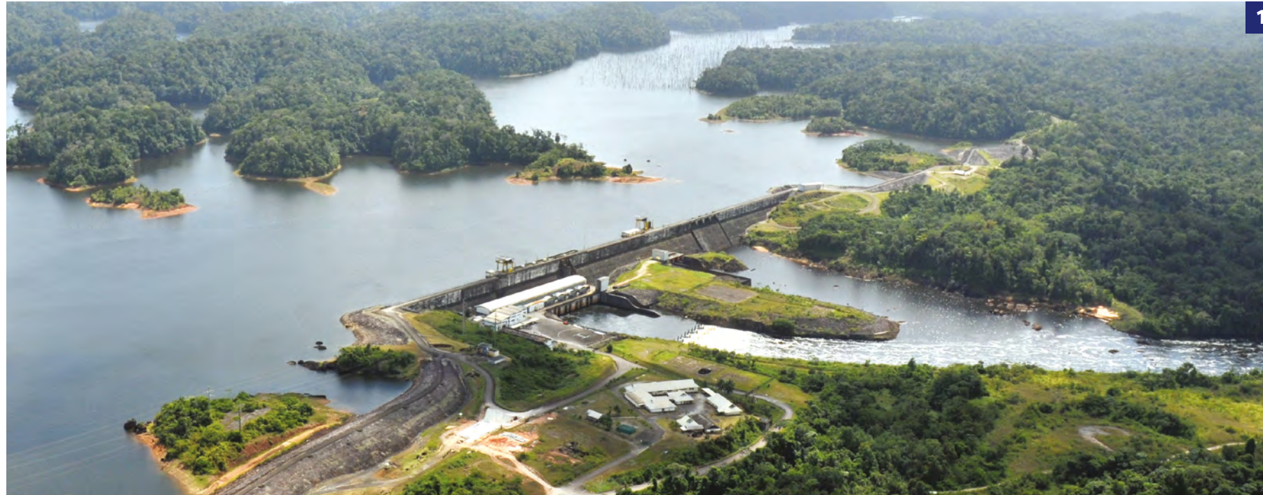
BARRAGE DE PETIT-SAUT
