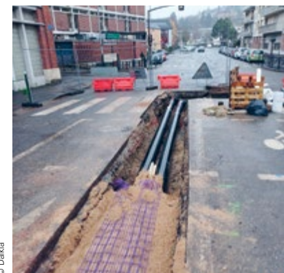
Travaux d'extension du réseau dans le quartier d'Hauteville de Lisieux.
