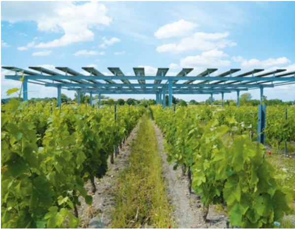
Le démonstrateur d'agrivoltaïsme Vitisolar et ses panneaux solaires, dans des vignes du Bordelais.
