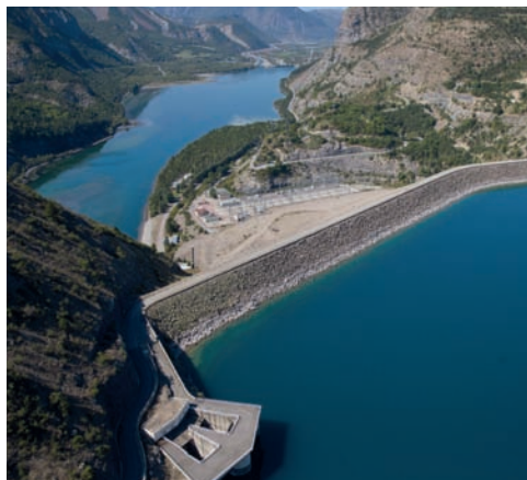
La production hydraulique est la première source d'énergie renouvelable en Provence-Alpes-Côte d'Azur.
