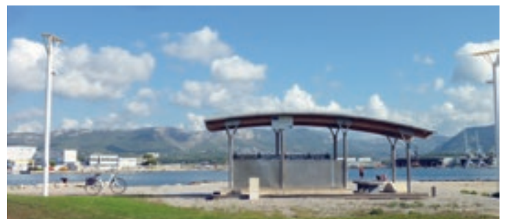
Dalkia a été choisie pour le développement, la gestion et l'exploitation du réseau urbain de la Seyne-sur-Mer, alimenté à 75 % par l'énergie renouvelable locale fournie par la Méditerranée.
