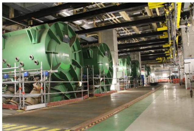
Les entrées d'eau du condenseur
