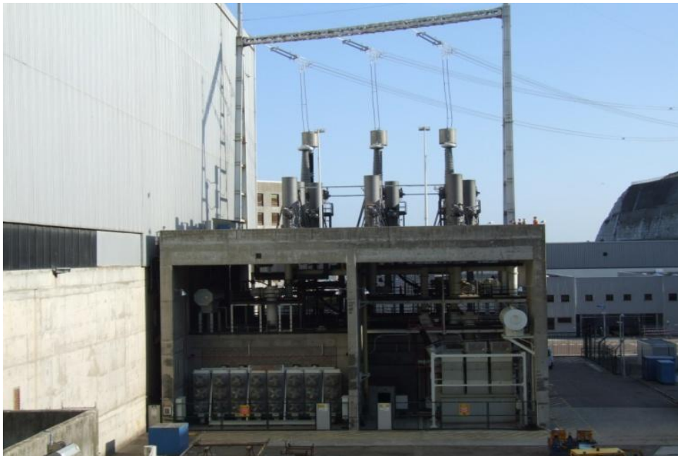
Le transformateur principal est situé en contrebas de la salle des machines.
